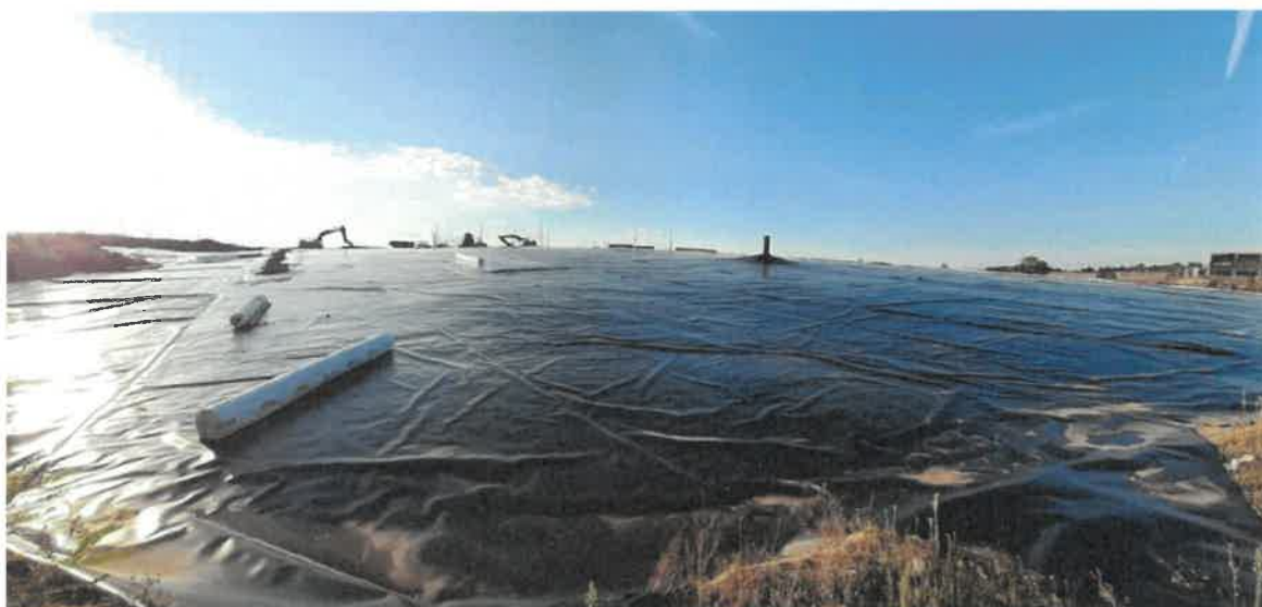
Pose de la géomembrane sur sous-couche argileuse.
