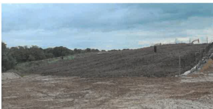
Mise en place de la terre végétale sur le complexe d'étanchéité.
