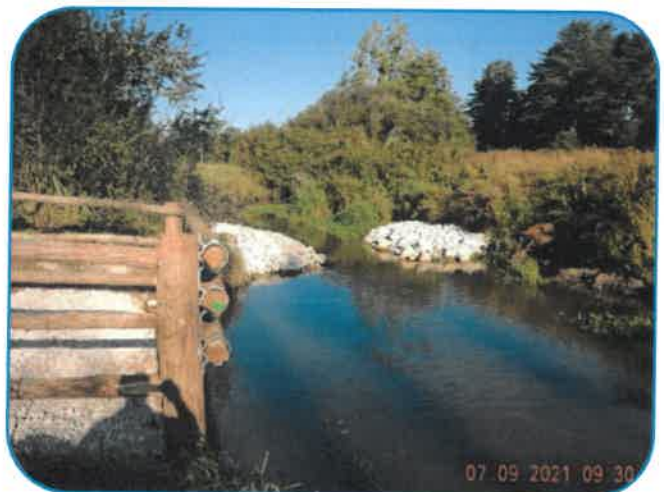
➔ Vue après travaux en aval de la descente
