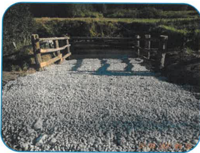
➔ Vue après travaux en amont de la descente
