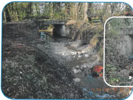
➔ Vue aval/amont du pont
