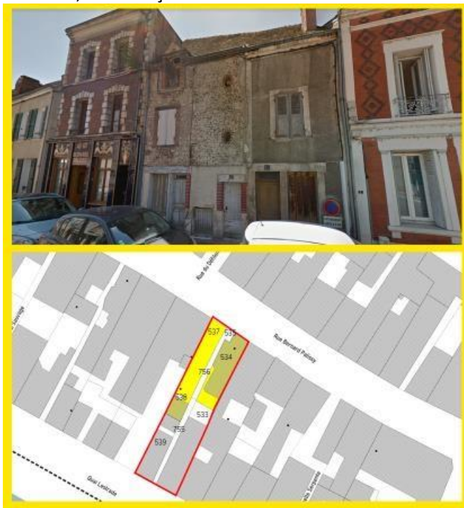
Situation au 65 et 67 rue Bernard Palissy, d'où sont prises les photos des façades.
