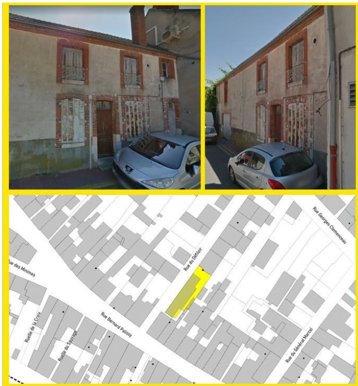
Situation au 4 rue du Défiloir
