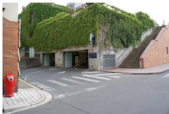
Accès au parking Jean Jaurès : 180 places
