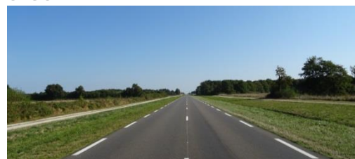
Figure 142 : La RD 940 au niveau de l'entrée dans le département sur la commune de Coullons
