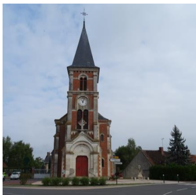
Figure 150 : Les Choux, place de l'Eglise
