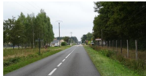
Figure 131 : Les Choux, entrée Est marquée par les extensions récentes
