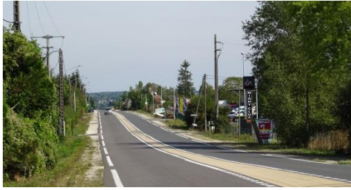
Figure 128 : La Ruellée en rive de la RD 940 à Poilly-lez-Gien
