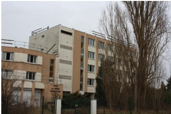
Photo 1 : Ancien Foyer des jeunes Travailleurs – démolition en 2017
