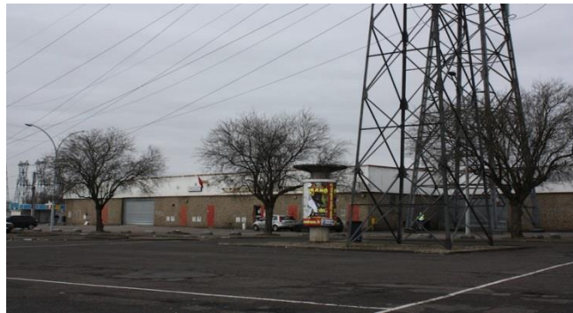
Photo 2: ancien centre commercial
