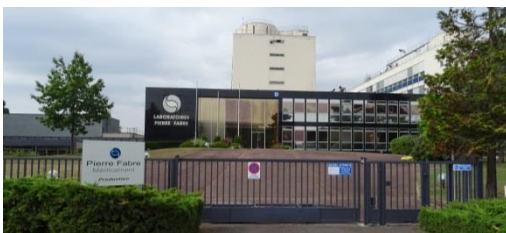
Figure 119 : Les laboratoires Pierre Fabre occupent une bonne partie de la zone d'activités Nord
