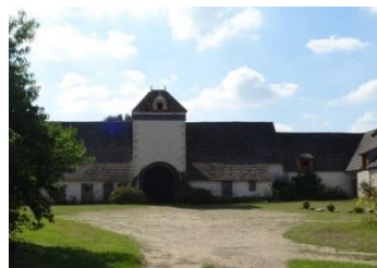
Figure 187 : Bâtiments à Nouan, commune de St-Gondon
