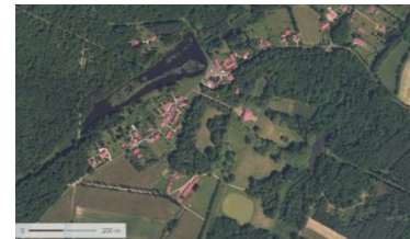
Figure 97 : Urbanisation diffuse de Langesse
