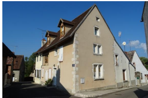
Figure 157 : Saint-Gondon, bâtiment R + 1 + combles
