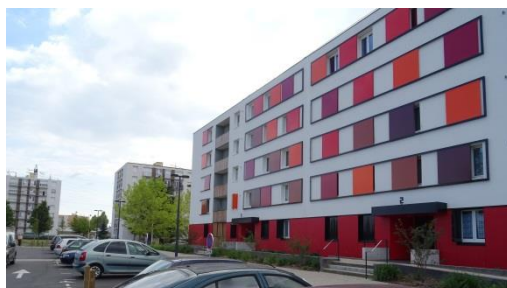
Figure 112 : Immeuble réhabilité rue des Cygnes, au Nord de Gien
