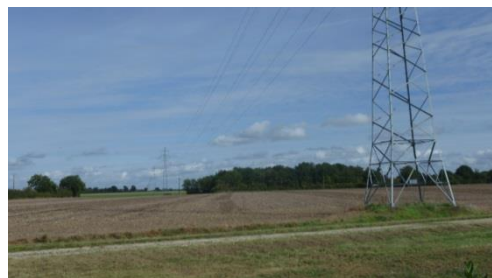
Figure 91 : Cultures céréalières traversées par une ligne haute tension
