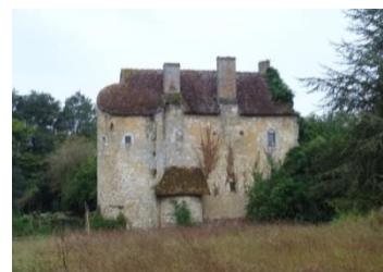
Figure 189 : le vieux château du Moulinet-sur-Solin
