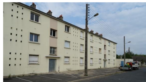
Figure 112 : Immeuble inoccupé aux abords du lycée
