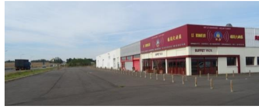
Figure 123 : bâtiments d'activités inoccupés en rive de la RD 940 à Poilly-lez-Gien
